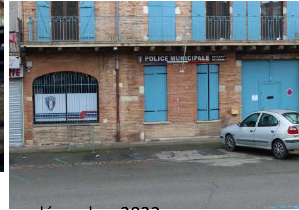
Nouveaux locaux de la police municipale
