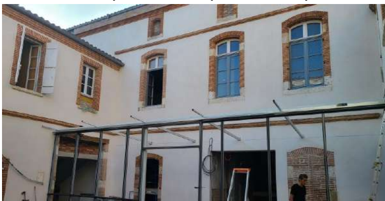
ACHÈVEMENT DES TRAVAUX MAISON FERMAT
