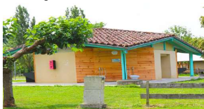
RÉNOVATION DE DEUX SANITAIRES À LA BASE DE LOISIRS
