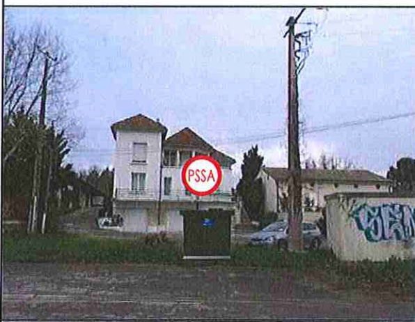
POSE D'UN TRANSFO. ELECTRIQUE POSTE PSSA "LA GIMONE" 82013 P.0109 à poser
